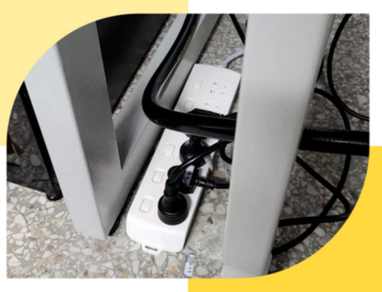
**安全风险：**接线板置于地面时，如出现积水、洒水等情况，存在断电或漏电风险
